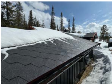
Mindre skjevheter på takflater
