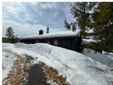
Nytt heldekkende pipebeslag på pipe fra stue/kjøkken
