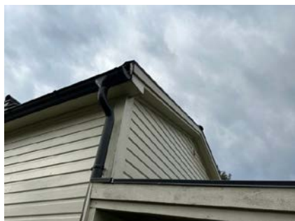
Takrenner og nedløp.
