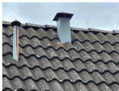
Beslag ligger ikke over takstein.
