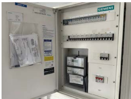
Sikringskapp. 2 strømmålere.
