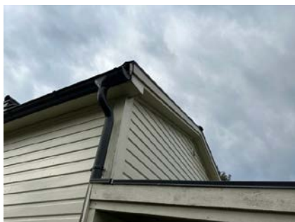
Takrenner og nedløp.
