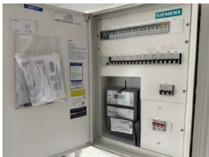
Sikringskapp. 2 strømmålere.
