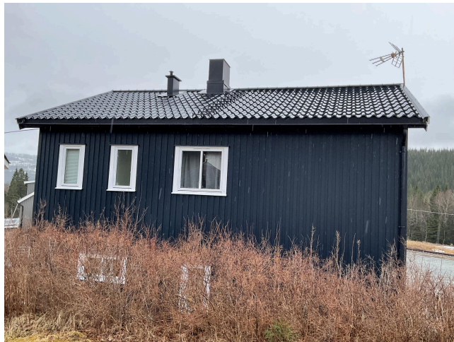
Profilerte metallplater. Taktekke har ikke snøfangere. Heng i takflate.
