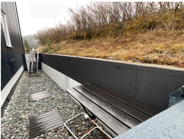
Øvre bakside med fuktsikring og mye pukk.
