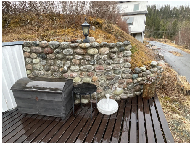
Forstøtningsmur med elvestein
