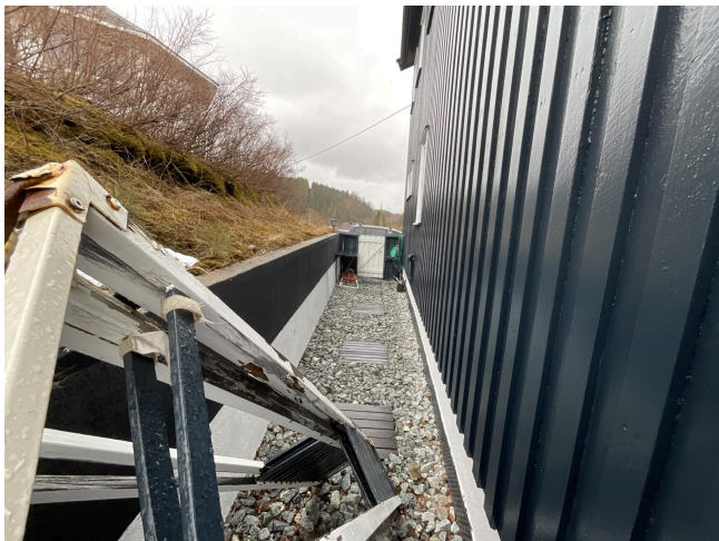
Forstøtningsmur på bakside
