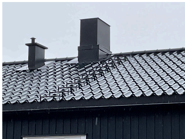
Utvendig pipe med helbeslått stål fra 1988
