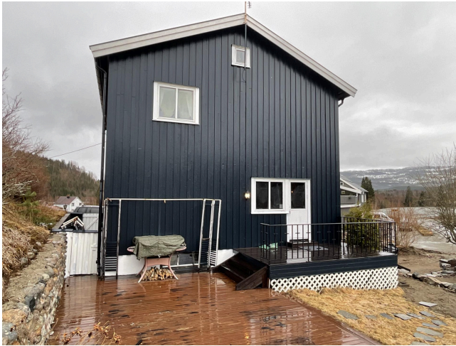
Veranda og treplattning anlagt på terreng.
