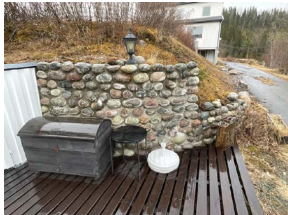
Forstøtningsmur med elvestein
