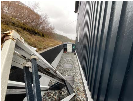
Forstøtningsmur på bakside
