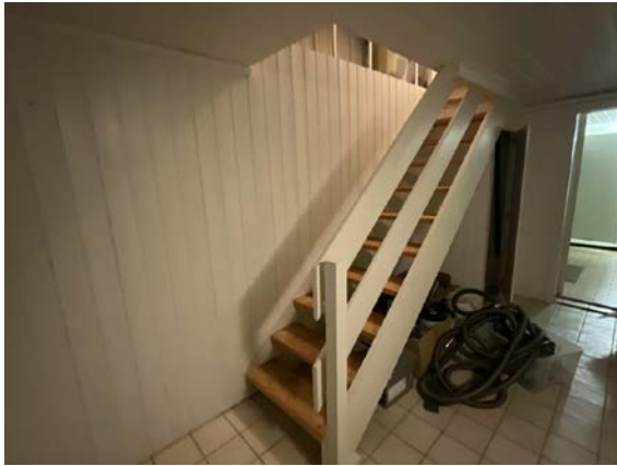
Kjellertrapp av tre. Åpen trinn samt lav takhøyde
