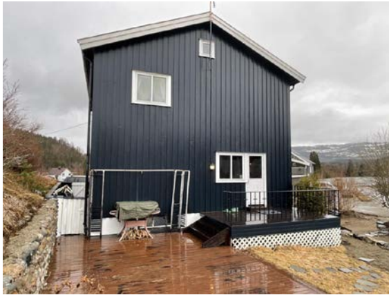
Veranda og treplattung anlagt på terreng.
