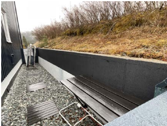
Øvre bakside med fuktsikring og mye pukk.
