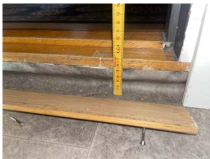
Tettesjikt ved dør
