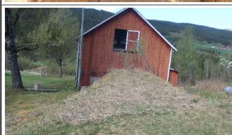
Låvebru er demontert.
