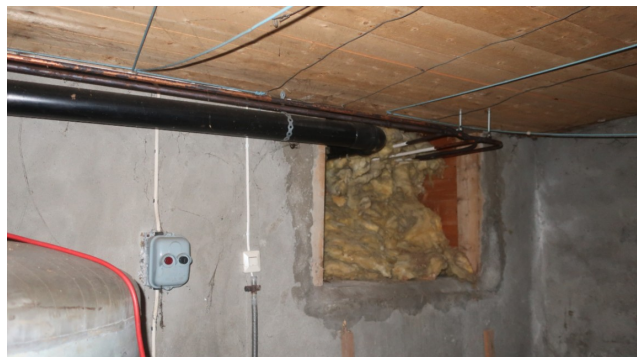
Krypkjeller under inngangsparti/bad er besiktiget fra teknisk rom.
