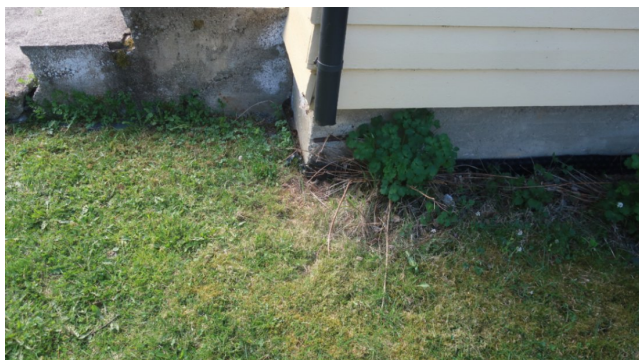
Avløp rett ned ved mur
