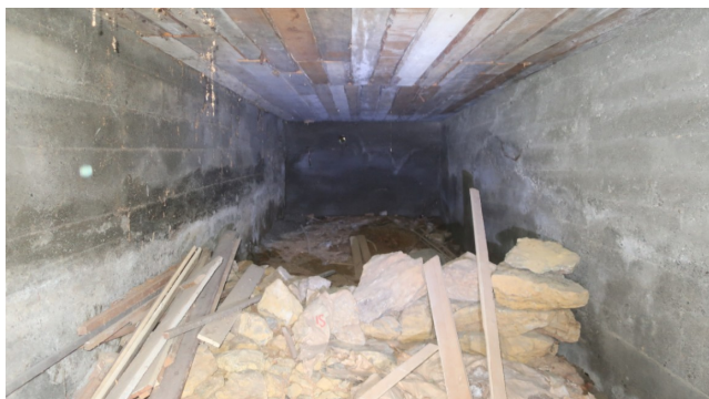
Krypkjeller under soverom, luke i mur.
