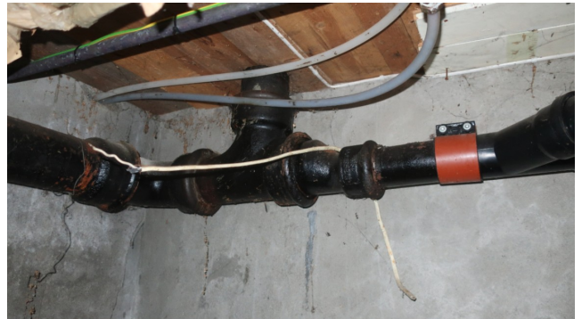
Jernrør fra vaskerom.
