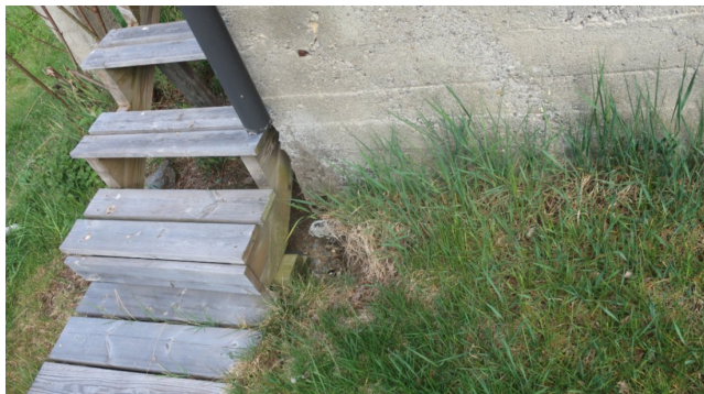
Avløp ved mur.
