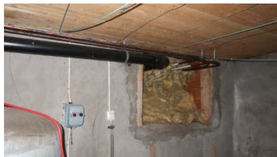
Krypkjeller under inngangsparti/bad er besiktiget fra teknisk rom.
