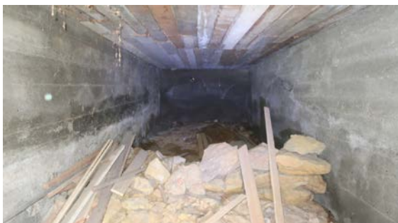
Kryp kjeller under soverom, luke i mur.
