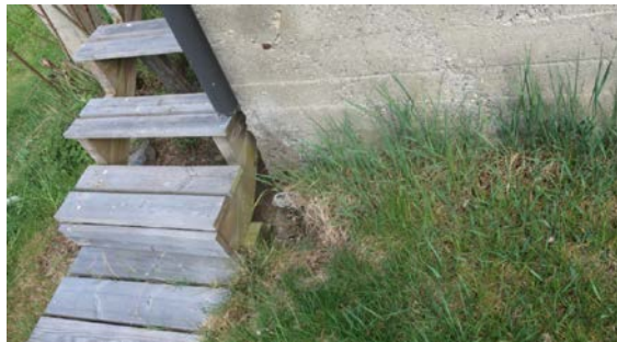
Avløp ved mur.
