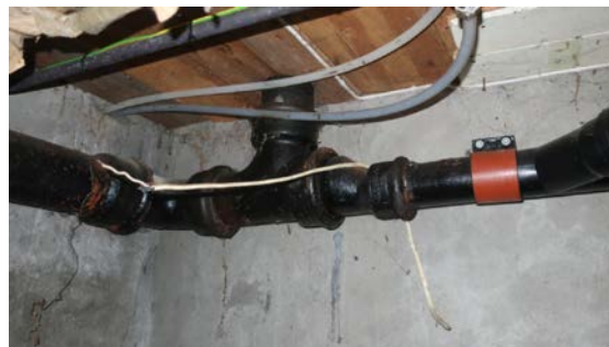
Jernrør fra vaskerom.
