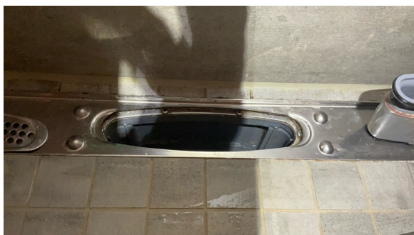
Kontroll av sluk.
