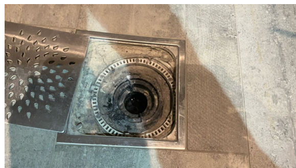
Kontroll av sluk.
