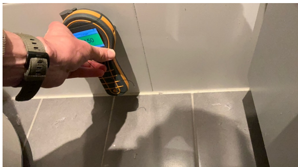
Enkle fuktsøk viste normale verdier på bad og vaskerom mot terreng.
