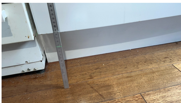
Helningsavvik på ca. 13 mm over en avstand på 2 meter i kjøkkenområdet.
