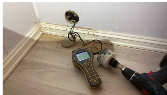
Hulltaking er utført, fuktmåling viste tørre verdier. 15 vektprosent viser at det er noe fuktpåkjenning, men ikke skadelige verdier. Dette må sannsynligvis sees i sammenheng med rom under terreng i rapporten. Det anbefales å følge med på videre utvikling.
