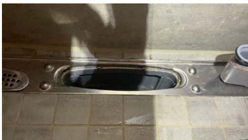
Kontroll av sluk.
