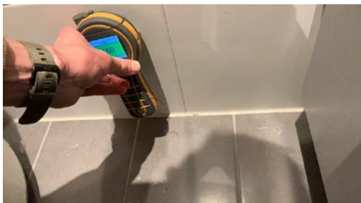
Enkle fuktsøk viste normale verdier på bad og vaskerom mot terreng.
