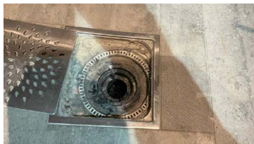
Kontroll av sluk.
