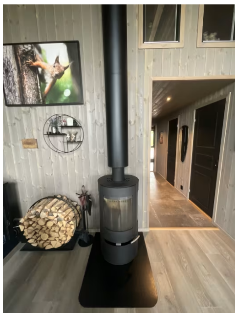
Viser ildsted montert i stue.
