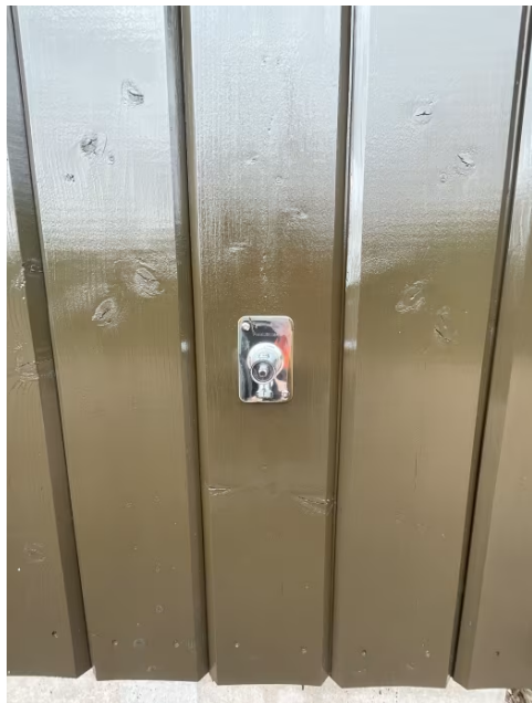
Viser utekran mot øst.
