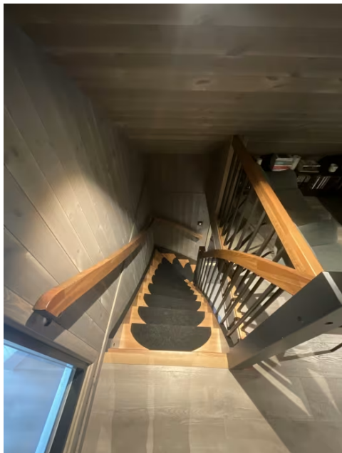
Viser trapp mellom 1 og 2.etasje.
