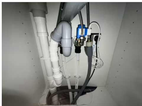
Viser vann og avløpsinstallasjoner under kum.
