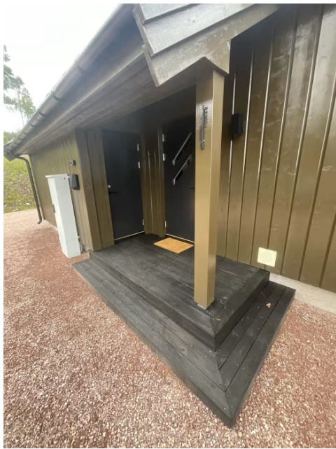
Viser plating ved inngangsparti.
