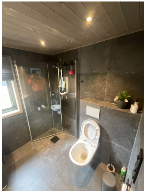
Viser toalett med innebygget systerne og dusjsone.
