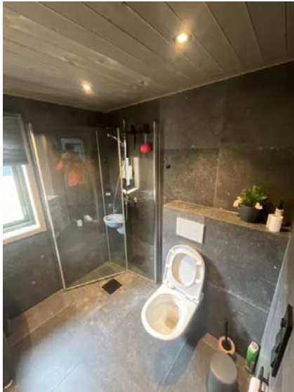
Viser toalett med innebygget sistene og dusjsone.
