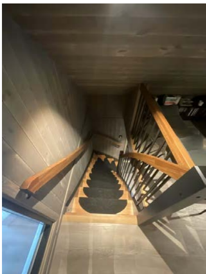
Viser trapp mellom 1 og 2.etasje.
