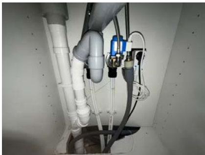
Viser vann og avløpsinstallasjoner under kum.
