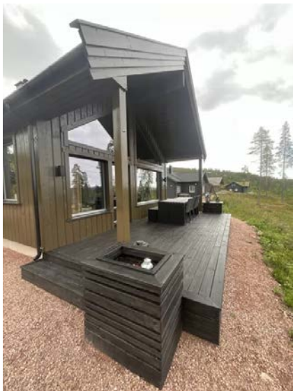
Viser delvis overbygget terrasse vendt mot sør/vest.
