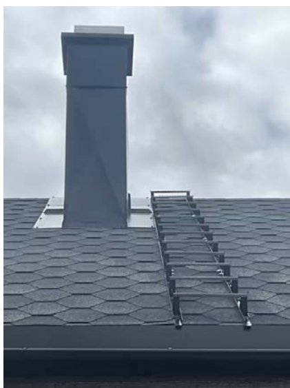
Viser pipebeslag og adkomst for feier.
