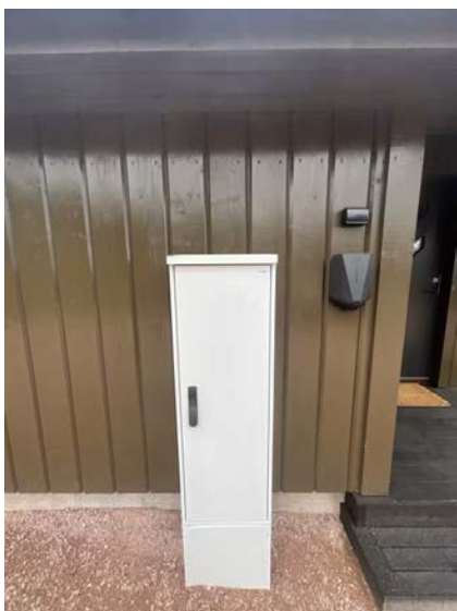
Viser inntakskap, easee elbillader og utestikk.
