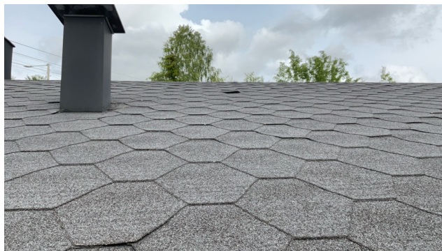
Utette overlapper og synlige spiker.
