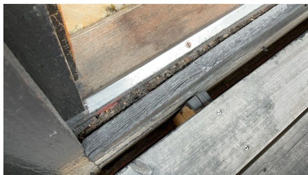
Utett mellom utvendig tetting og karm.
