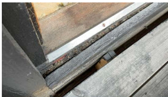
Utett mellom utvendig tetting og karm.
