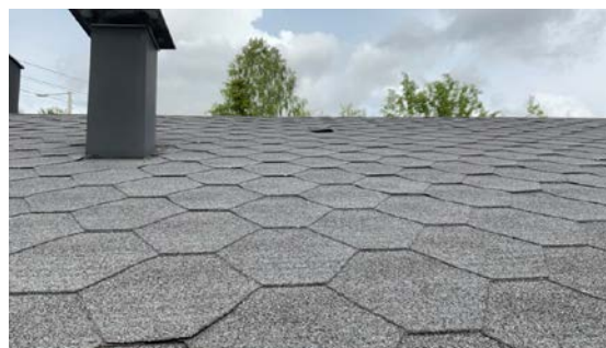
Utette overlapper og synlige spiker.
