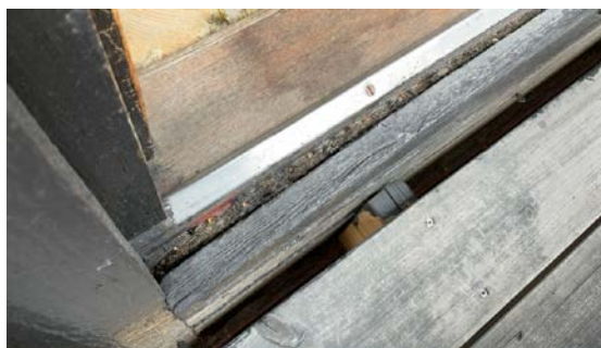
Utett mellom utvendig tetting og karm.
