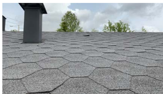
Utette overlapper og synlige spiker.
