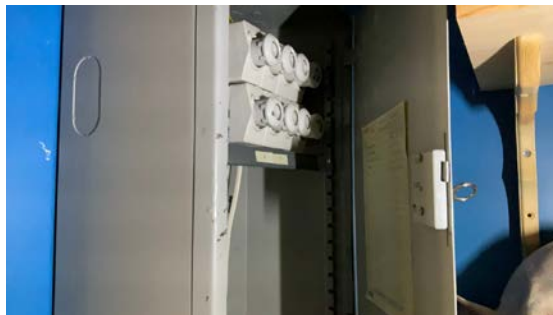
Sikringsskap hybel.
