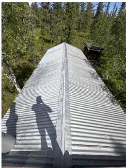
Viser tak tekket med metallplater.
