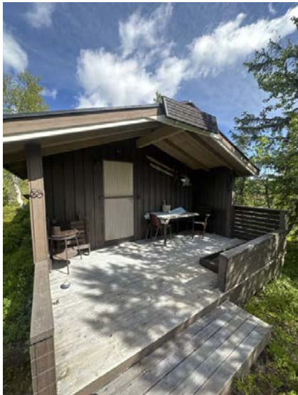
Viser terrasse/ overbygget inngangsparti mot sør.
