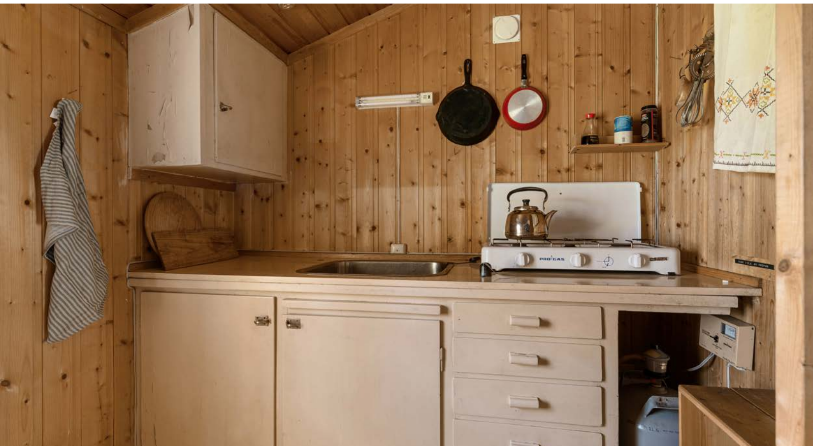
Eldre og plassbygd innredning med heltre skrog og finerte fronter. Laminert benkeplate med nedfelt servant. Eget rom for gassbeholder til koketopp med 3 gassbluss.
