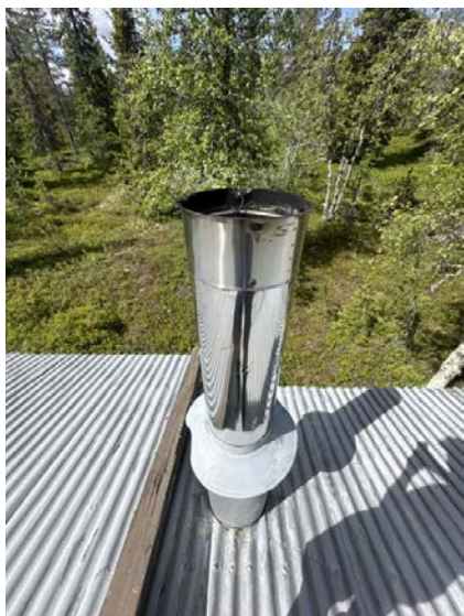
Viser pipe og beslag over tak.
