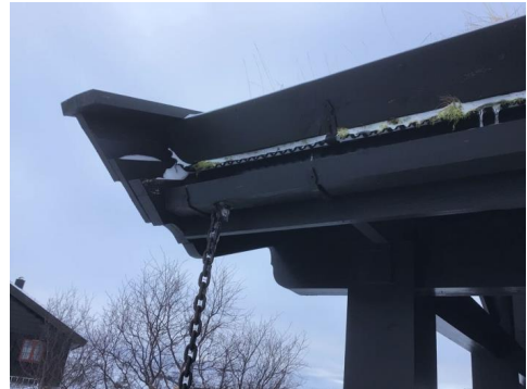
Tre renne med kjetting som nedløp
