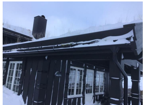
Ny stål renne og nedløp mot vest
