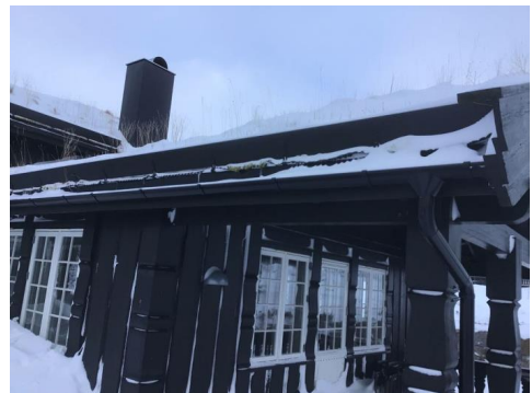
Ny stål renne og nedløp mot vest
