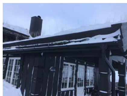
Ny stål renne og nedløp mot vest
