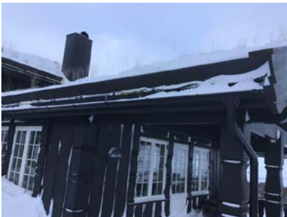
Ny stål renne og nedløp mot vest
