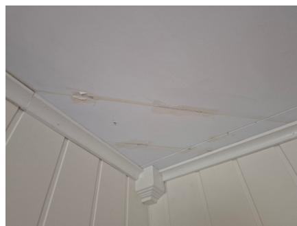
Merker i tak etter tidligere vegg.
