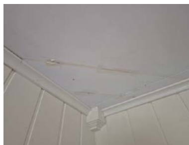
Merker i tak etter tidligere vegg.
