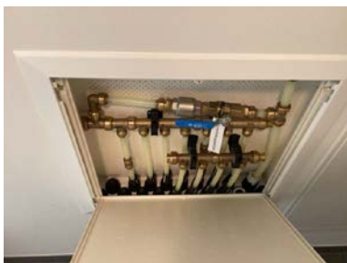
Kontroll av rørskap.
