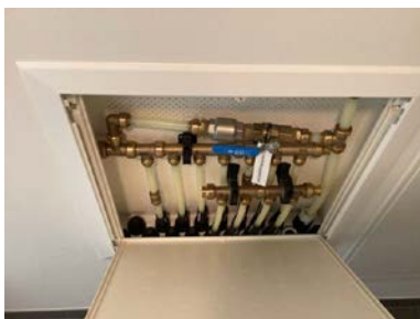
Kontroll av rørskap.
