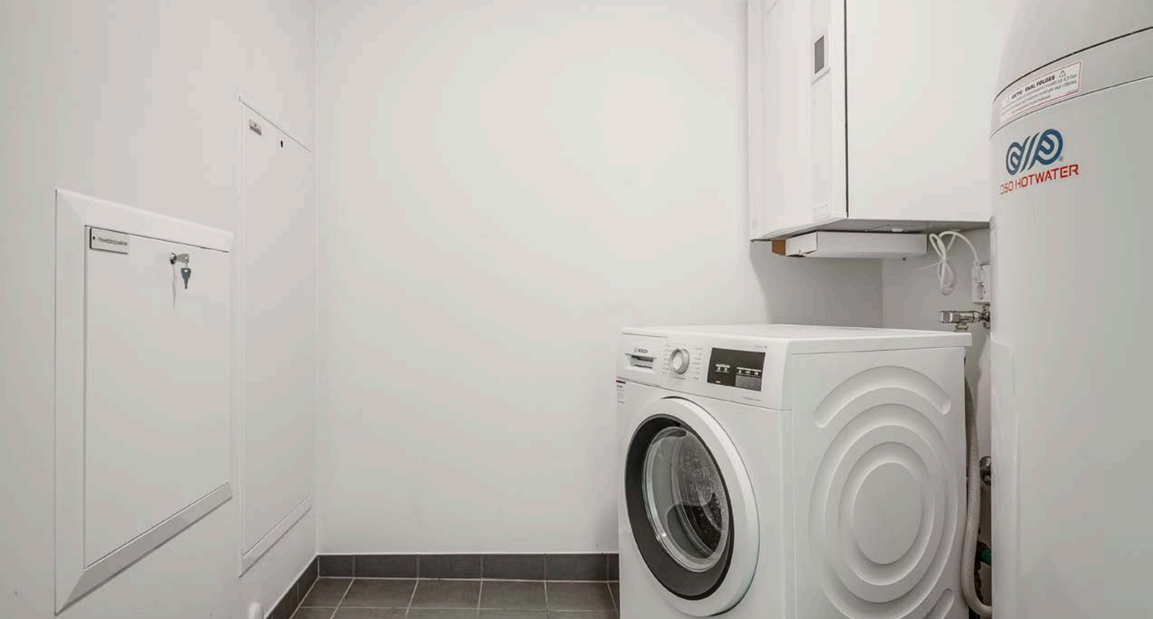
Leiligheten har også et praktisk vaskerom/teknisk rom med flislagt gulv.
