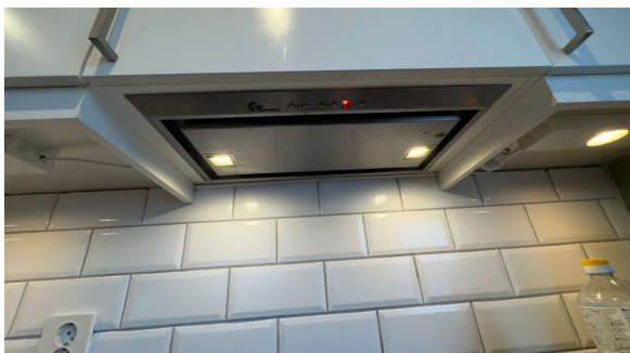
Kontroll av avtrekk.
