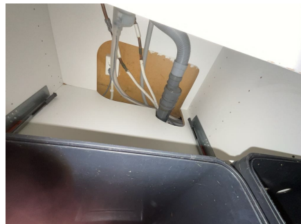
Del av rør til avløp.
