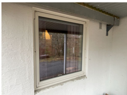
Eksempel på vindu i yttervegg.
