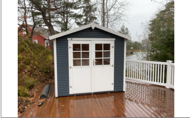
Enkel bod oppført på eiendommen.
