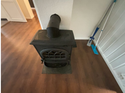
Montert ovn i stue.
