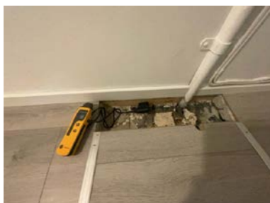
Hull for kontroll av fukt.
