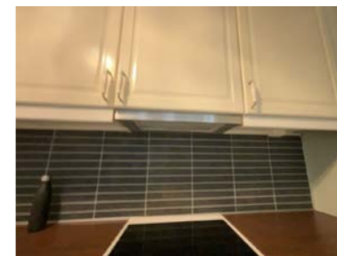
Montert avtrekk over komfyr.
