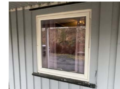
Eksempel på vindu i yttervegg.
