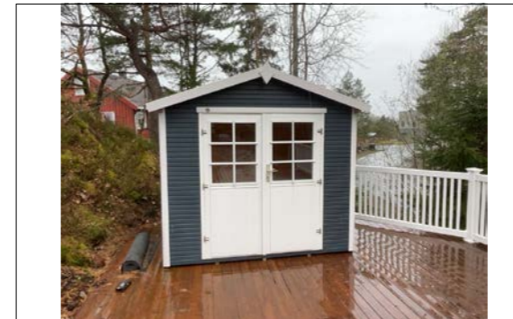
Enkel bod oppført på eiendommen.
