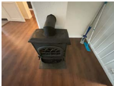
Montert ovn i stue.
