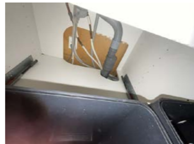
Del av rør til avløp.
