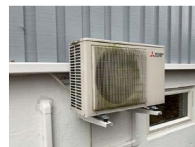
Varmepumpe ytterdel.
