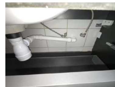
Del av rør til vann.
