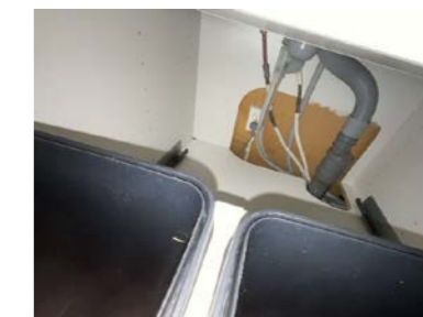
Del av rør til vann.
