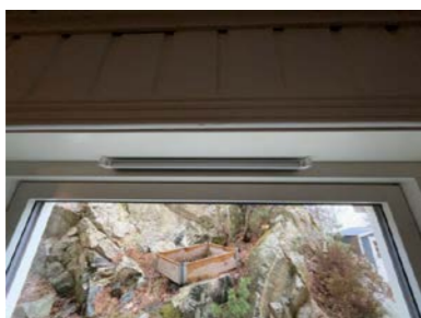
Eksempel på montert ventil i vindu.
