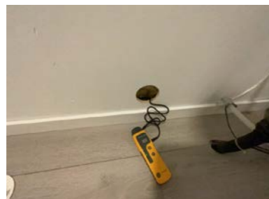
Hull for kontroll av fukt.
