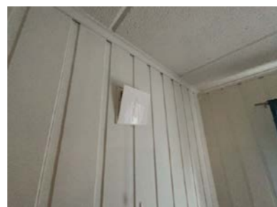
Eksempel på montert ventil i vegg.
