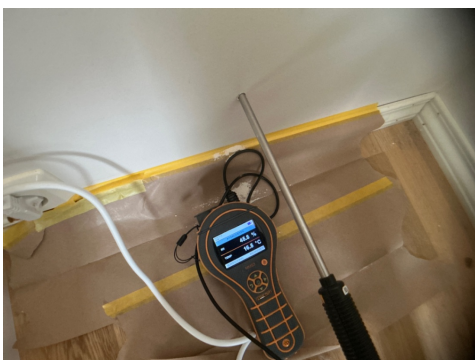
UNDERETASJE > BAD - 7.5M2
