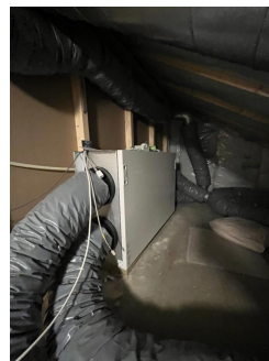
Balansert anlegg plassert på kryploft
