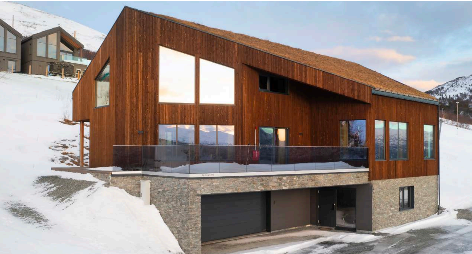
Fasade - romslig terrasseløsning og overbygd inngangsparti
