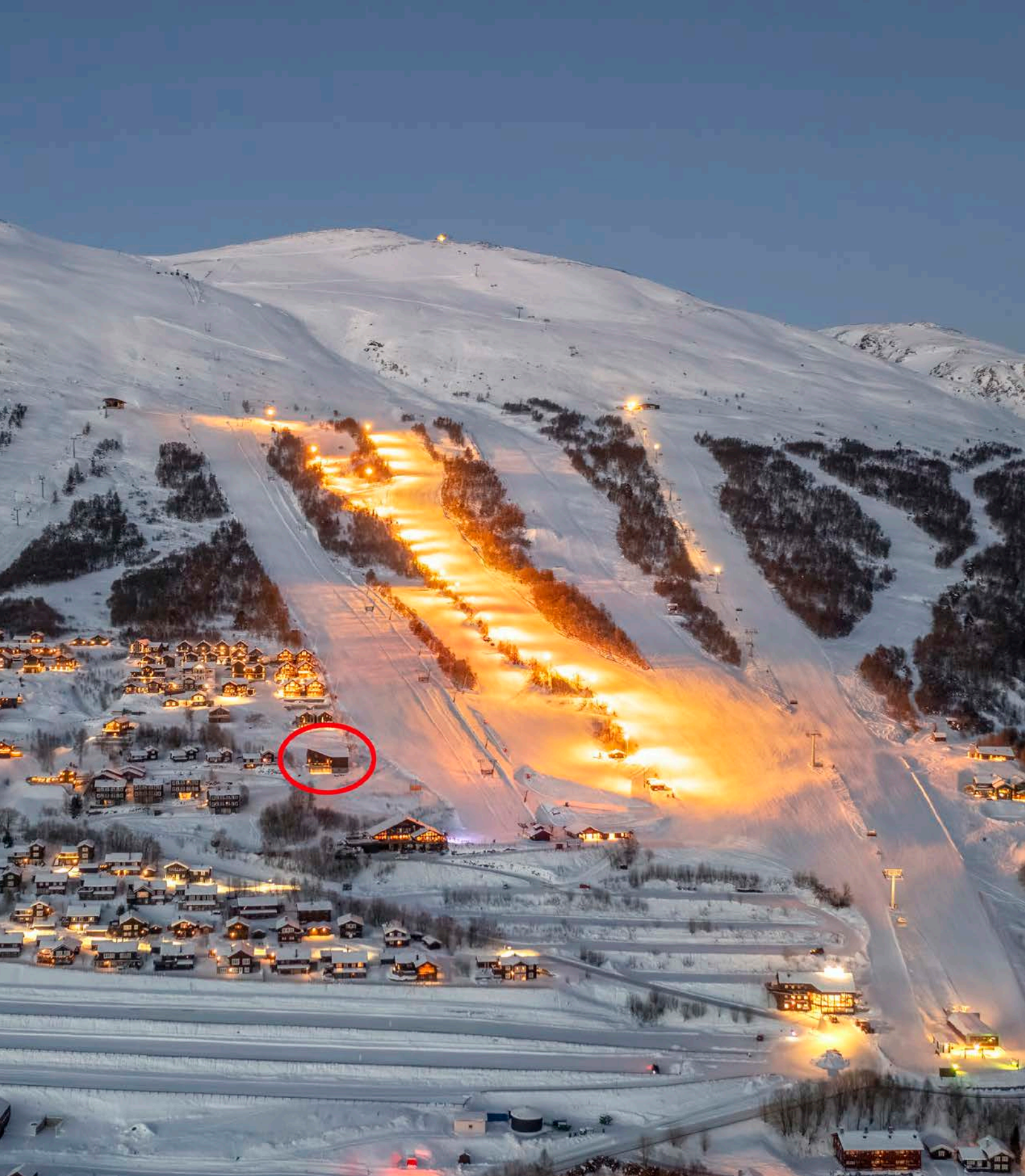
Oversiktsbilde med markering
