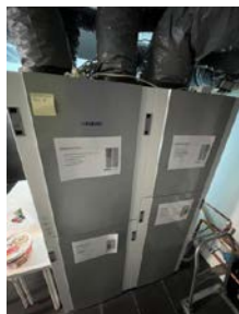
Ventilasjonsmodul plassert sammen med varmepumpe nede på teknisk rom
