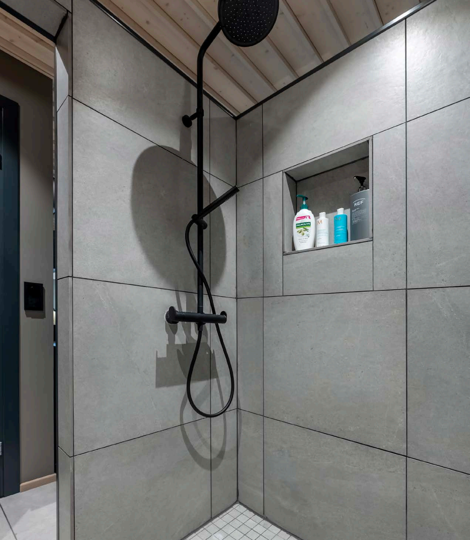
Lekker dusjløsning (sokkeletasje)
