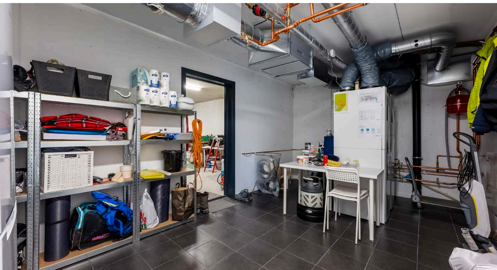
Teknisk rom med god plass (sokkeletasje)
