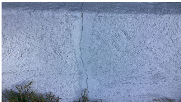
Eksempel på utvendig skråriss.
