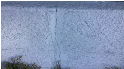
Eksempel på utvendig skråriss.
