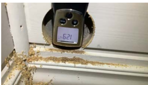
Hulltaking, og det måles tørr.
