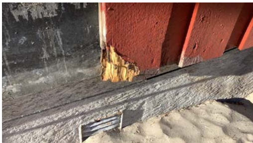
Skadet kledningsbord.
