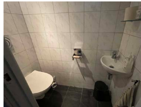
Separat toalett i underetasje
