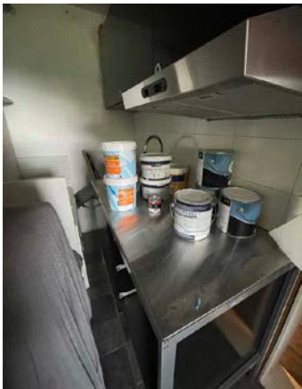
Grovkjøkken i underetasje
