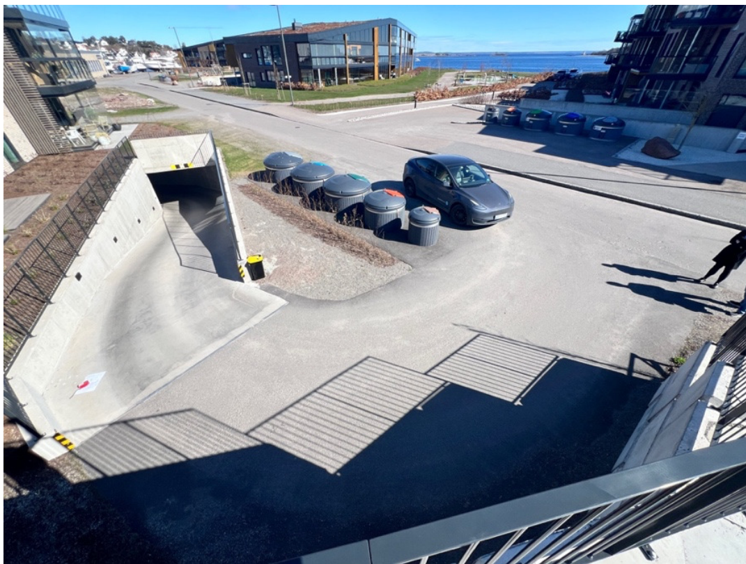
Avkjøring og nedkjøring til parkeringskjeller. (Foto: Holar Ola Roald AS).
