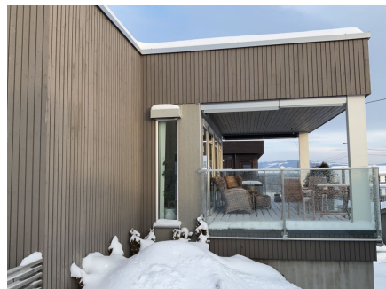
Utvendig kledning med trepanel og fiberplater
