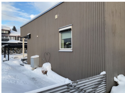
Utvendig kledning med trepanel
