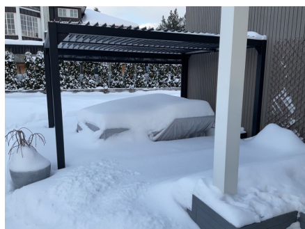
Terrasse og pergola på befaringstidspunktet
