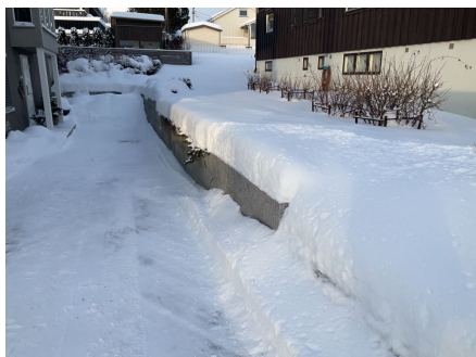
Forstøtningsmur ved befaringen
