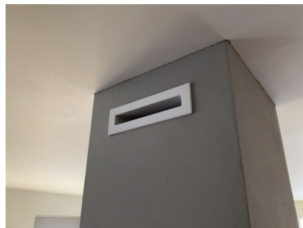
Lufting/ inspeksjon innebygd stålpipe
