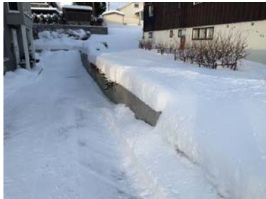
Forstøtningsmur ved befaringen
