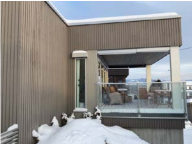
Utvendig kledning med trepanel og fiberplater
