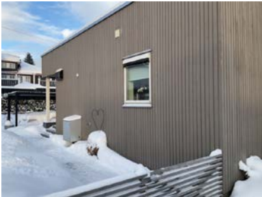
Utvendig kledning med trepanel
