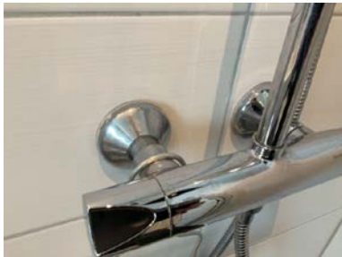
Rørgjennomføringer
