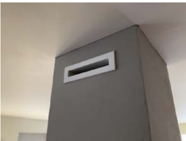
Lufting/ inspeksjon innebygd stålpipen
