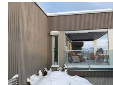
Utvendig kledning med trepanel og fiberplater
