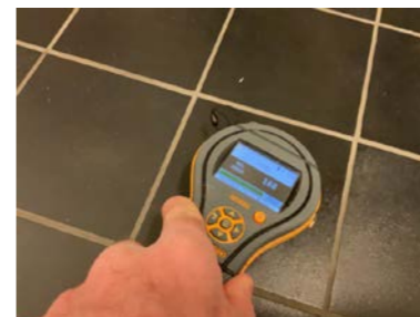
Ved fuktsøk på gulv er det ikke registrert måleverdier som indikerer fukt.
