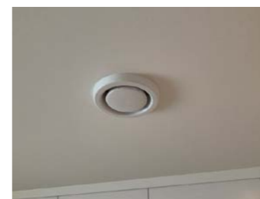
Ventil for avtrekk
