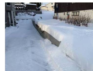
Forstøtningsmur ved befaringen
