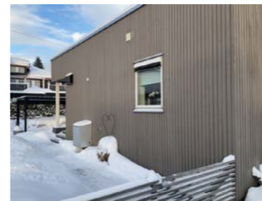
Utvendig kledning med trepanel
