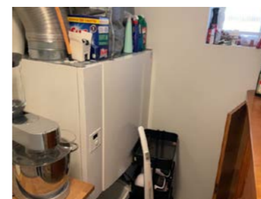
Ventilasjonsaggregat
