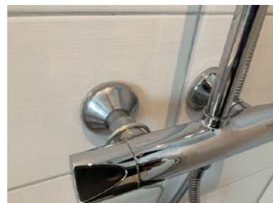
Rørgjennomføringer
