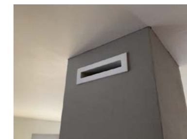
Lufting/ inspeksjon innebygd stålpipes
