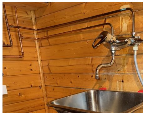
Kobberrør fra byggeår
