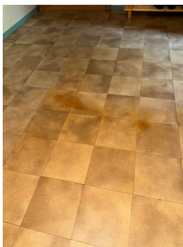
Flere løse vinylfliser på kjøkken
