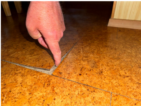
Flere løse vinylfliser på kjøkken
