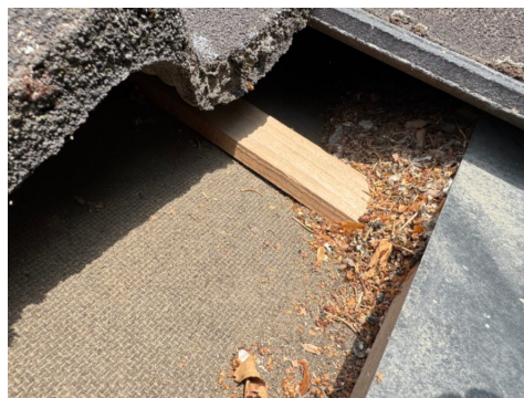
Undertak av Sutak fra byggeår.
