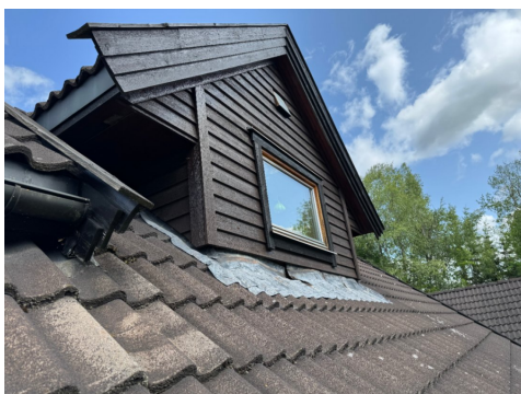
Uttett vegg/tak beslag
