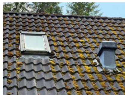
Takflate mot nord
