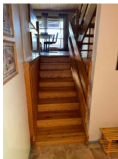
Åpninger mellom trinn 12,5 cm
