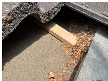
Undertak av Sutak fra byggeår.
