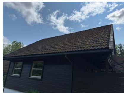
Takflate mot nord
