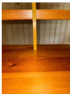
Åpninger mellom trinn 12,5 cm
