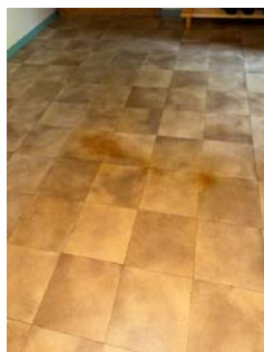
Flere løse vinylfliser på kjøkken
