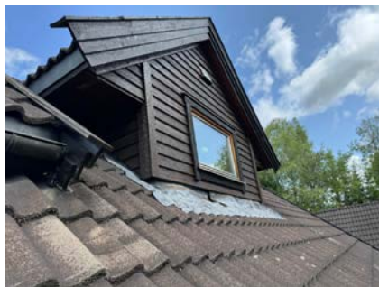
Uttett vegg/tak beslag
