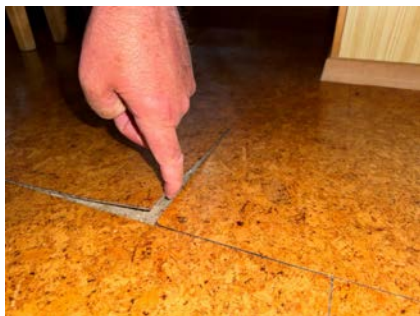
Flere løse vinylfliser på kjøkken
