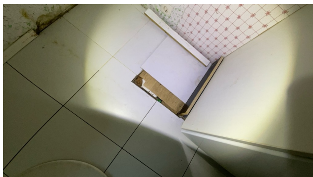
Åpning i gulv i kjøkken.
