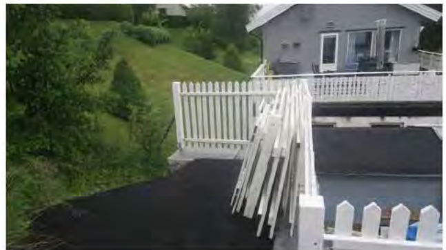
I det nordvestre hjørnet av oppkjøringen er det asfaltert mot muren.
