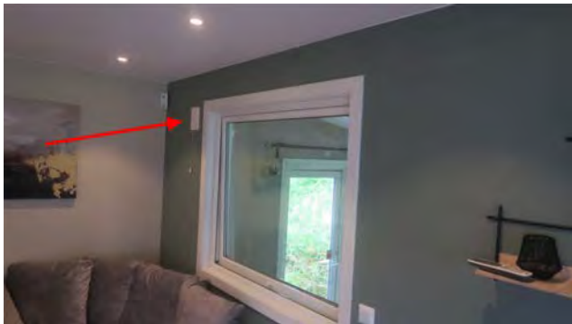
Det er en luftenventil i opprinnelig yttervegg.
