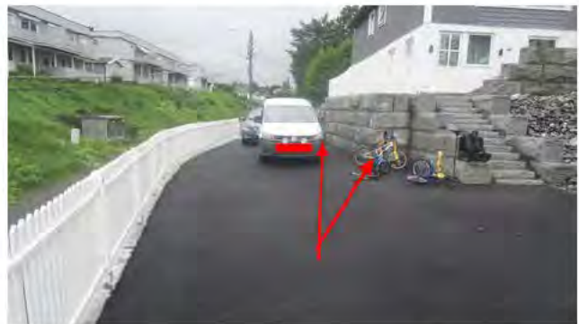
Søttemur med trapp opp til inngangsparti. Målinger med laser er utført i hver ende av denne muren.
