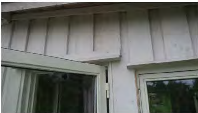
Dør og vindu på tilbygg.
