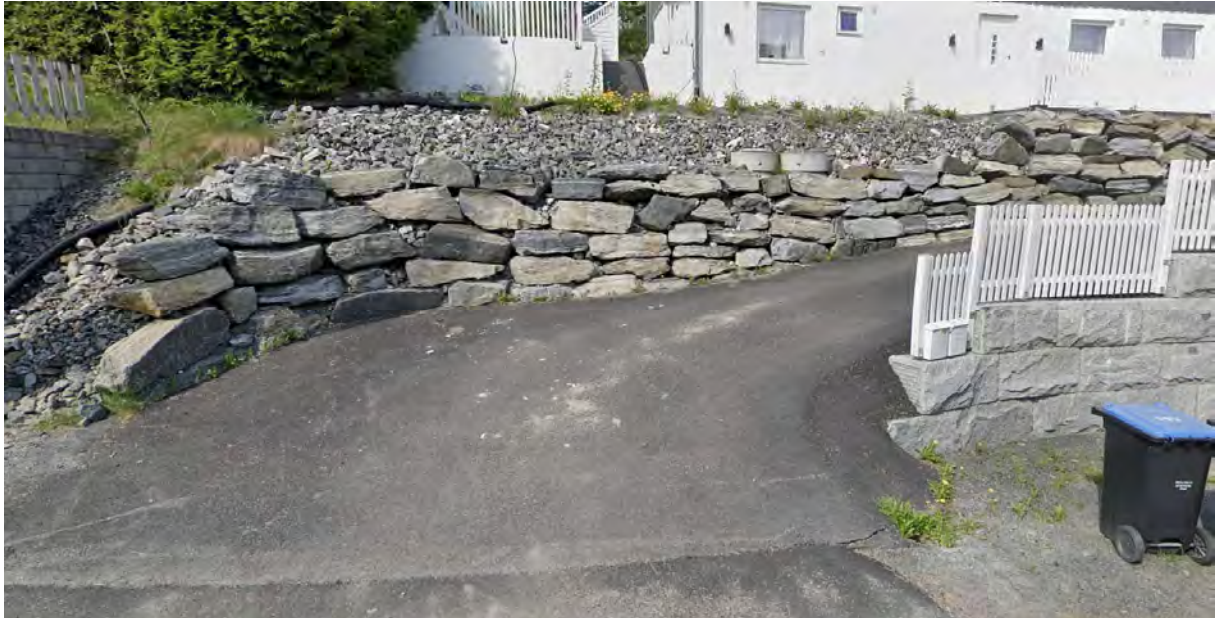
Figur 7: Oversikt over mur i naturstein ved innkjørsel til bolig.
