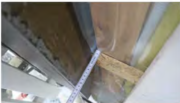
23 mm leker på kledning er for tynn for tømmermannskledning med cc 600 mm mellom stendere.
