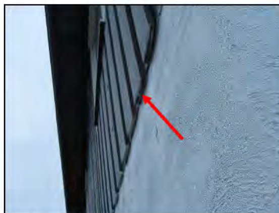
Ikke et godt bilde, men enkelte steder er det pusset noe ut på underliggende kledningsbord. Delvis er luftingen forringet.
