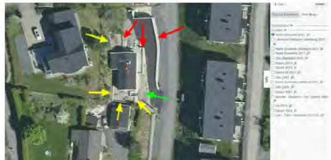
Bilde hentet fra Norge i bilder fra 2021 viser ferdig asfaltert oppkjøring, ferdige støttemurer av lettklinkerblokker og stablemurer. Rød pil=Granittmur stablet, grønn pil=sprengsteinsmur, gul pil=mur av lettklinkerblokker
