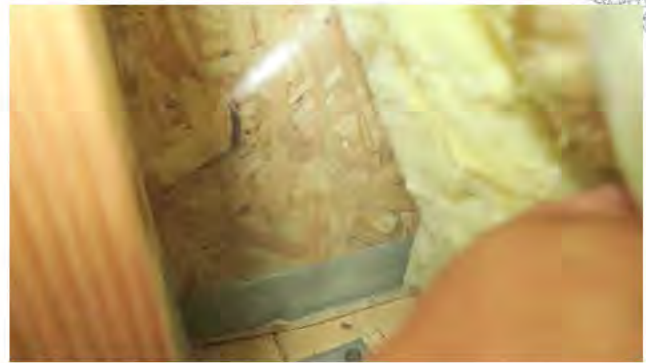
Plast og OSB på innsiden med isolasjon i mellom. Konstruksjonen må bygges om for å bli fagmessig.
