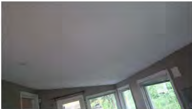
Himling i tilbygg med innfelt belysning og malte flater.
