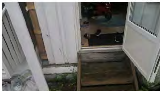
Overgang yttervegg opprinnelig hus/tilbygg.
