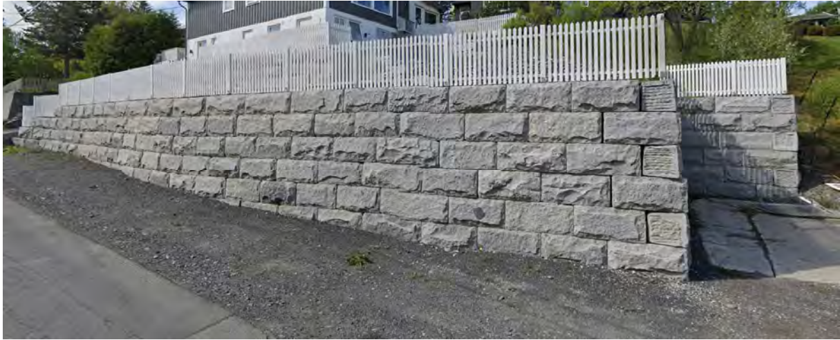
Figur 3: Oversikt over nedre mur mot Skoleveien.
