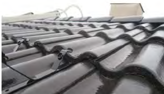
Man ser tydelig forskjell på hvordan steinene ligger der det er stigetrinn/konsoller og der det ikke er det.
