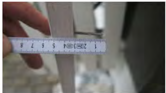
Overligger festet med 55 mm spiker. Spiker gikk kun ca 10 mm inn i sløyfe. Lenger spiker må benyttes.
