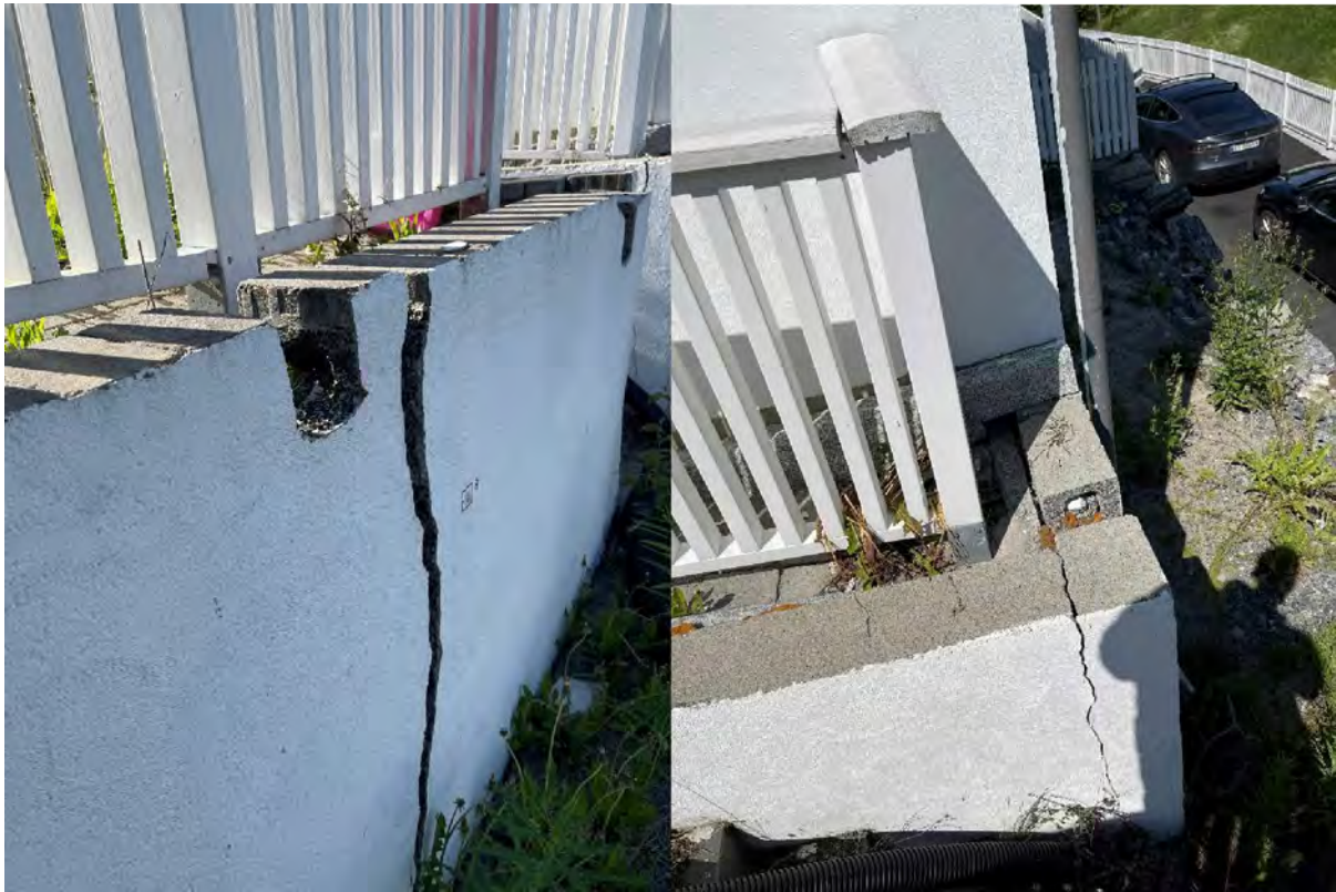
Figur 14: Punkt 16 er plassert på støttemur (bildet til venstre) og punkt 15 er plassert på støttemur ved boligens sørøstlige hjørne (bildet til høyre) like ved en trapp. Det er etablert drenering i toppen av støttemurene, se utspæringer i topp mur.
