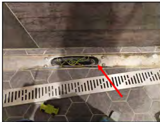
Ingen membran under klemring. Jording ikke tilkoblet
