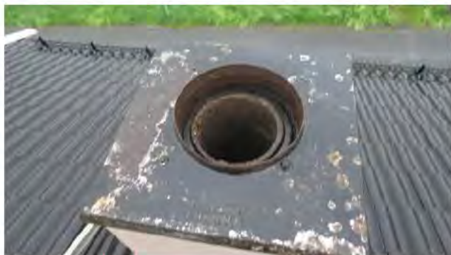
Pipe sett fra yttertak.
