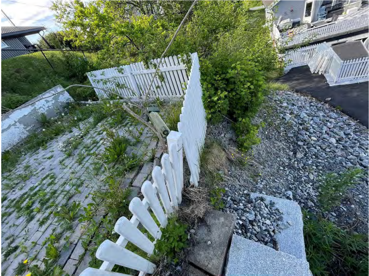
Figur 13: Innsynkning av terreng mot nord (der det ikke er støttemur) tyder også på at massene i disse skrånningene er i bevegelse.
