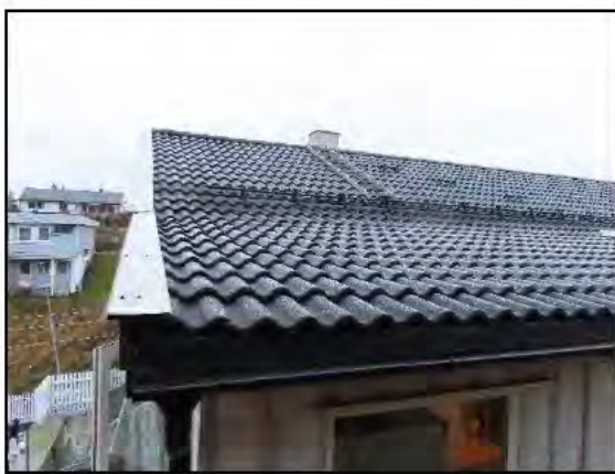
Bilde viser takflate
