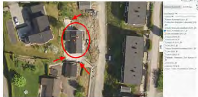
Bilde hentet fra Norge i bilder fra 2017 viser at store deler av eiendommen har blitt gravet ut. Taket er også lagt om, også over tilbygget mot vest. Støttemurer i lettklinkerblokker og terrasser er påbegynt på dette tidspunkt.
