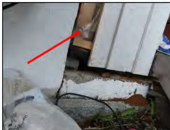
Dampspørre på kald side av yttervegg
