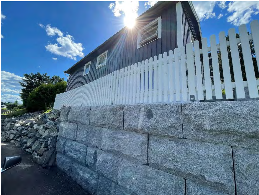
Figur 8: Støttemur nedenfor boligen, stablede granittblokker og del av mur i naturstein ved innkjørsel.
