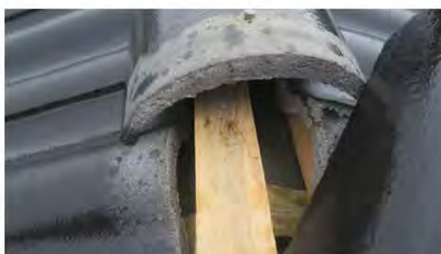
Mønepanner er feilmontert. Det er ikke luftbånd over mønekam, mønestein hviler kun på takstein, ikke på mønekam, , stein er ikke fuget, mønestein er spikret med galvanisert spiker og omlegget dekker såvidt sikkerhull.
