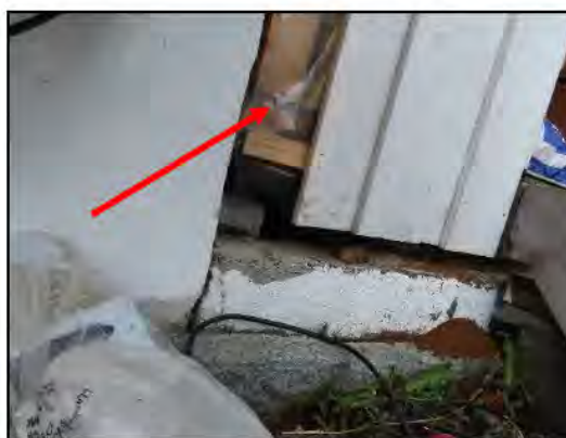
Dampsperre på kald side av yttervegg
