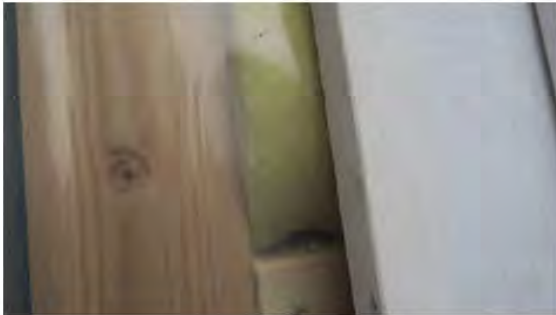
Plast på utsiden.
