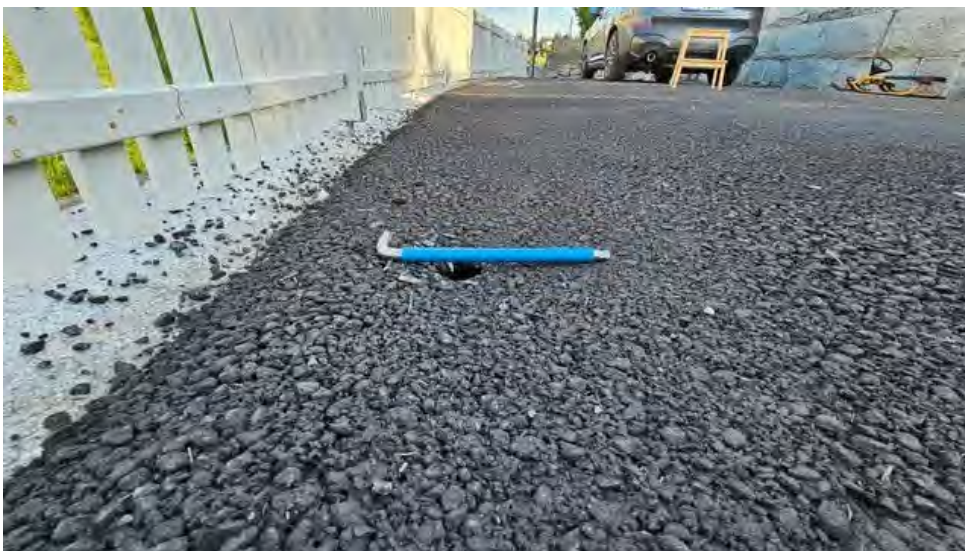
Figur 6: Hull i asfalten inn mot støttemur ved Skoleveien. Bilde oversendt av boligeier, [REDACTED].
