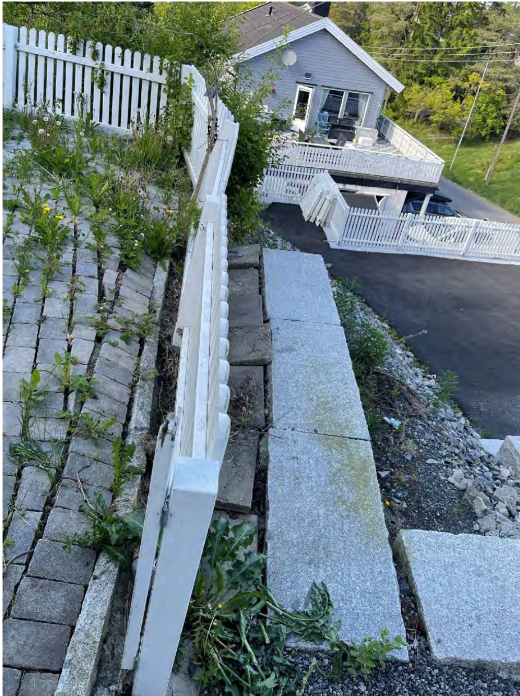
Figur 12: Terreng og støttemur på boligens nordside. Trapp ligger til høyre i bildet.
