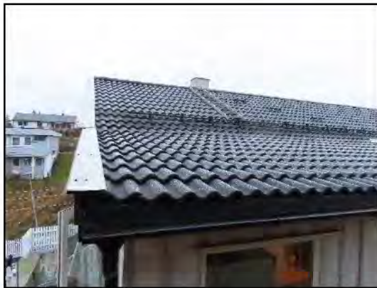
Bilde viser takflate
