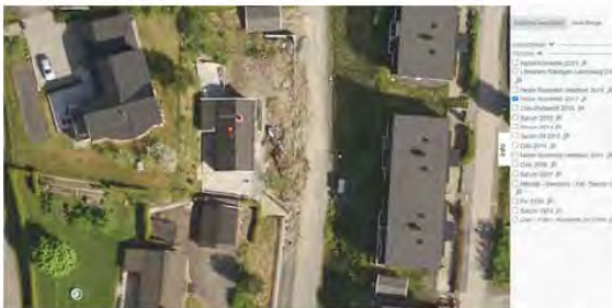
Flyfoto fra norgebilder.no fra 2017 viser ta både hovedtak og tak over tilbygg er lagt om. Taket er skiftet i tidsrommet 2016/2017.
