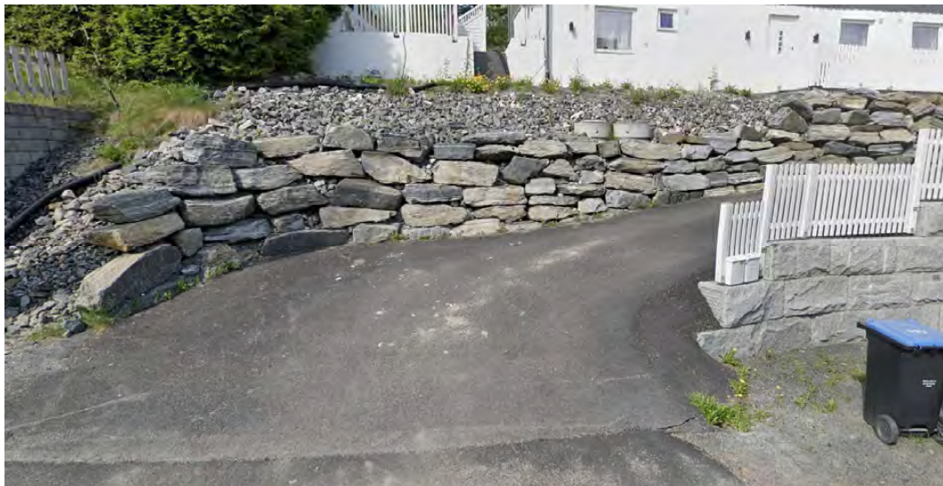
Figur 7: Oversikt over mur i naturstein ved innkjørsel til bolig.
