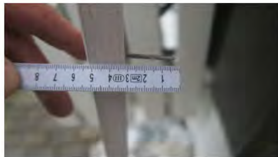
Overligger festet med 55 mm spiker. Spiker gikk kun ca 10 mm inn i sløyfe. Lenger spiker må benyttes.
