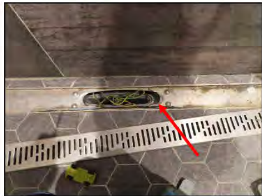
Ingen membran under klemring. Jording ikke tilkoblet
