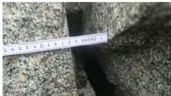
Det er 6 cm glippe i toppen. Det er ikke kjent hvordan dette har sett ut når dette var nytt.
