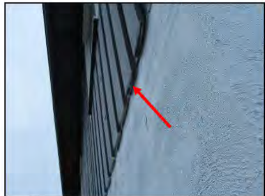
Ikke et godt bilde, men enkelte steder er det pusset noe ut på underliggende kledningsbord. Delvis er luftingen forringet.
