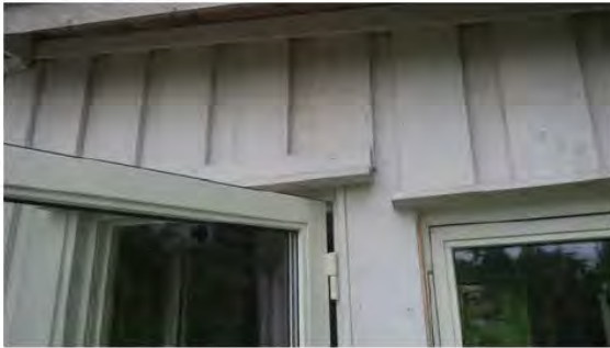
Dør og vindu på tilbygg.
