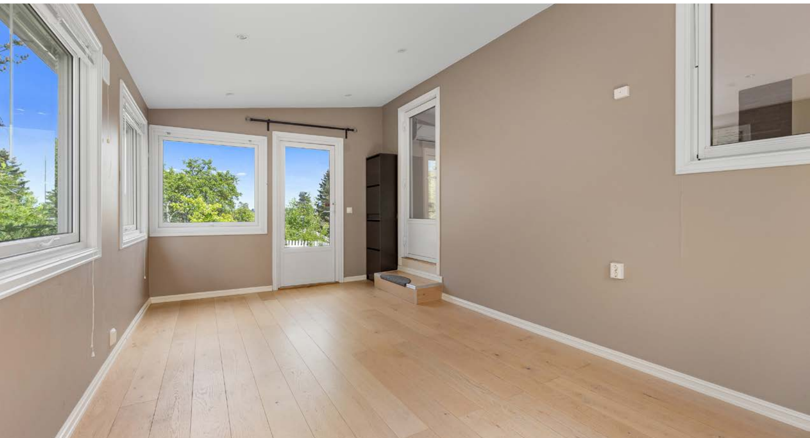
Vinterhage med terrassedør. (Tilbygget er ikke lovlig oppført). Interessenter oppfordres til å lese gjennom vedlagte skaderapporter og tilstandsrapport.
