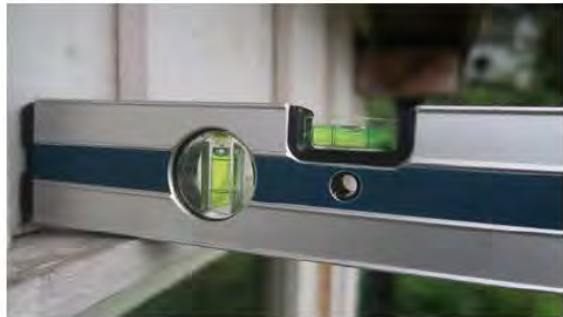
Motfall på vannbrett gjør at vann ledes inn mot veggen o stedet for vekk fra veggen.
