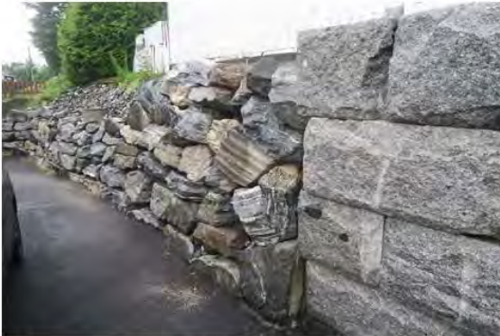
Overgang fra granittblokk-mur til steinmur med mer tilfeldig oppstabling.
