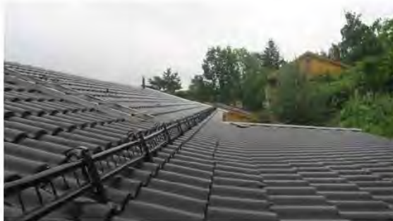
Snøfangerne er montert på taket.
