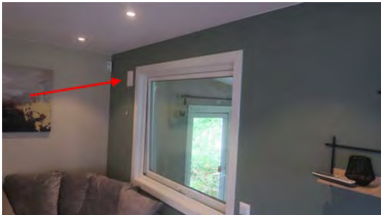
Det er en lufteventil i opprinnelig yttervegg.
