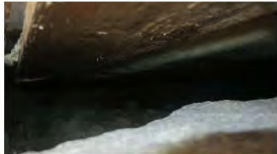
Bjelkelag henger i luften over gammelt steingulv.
