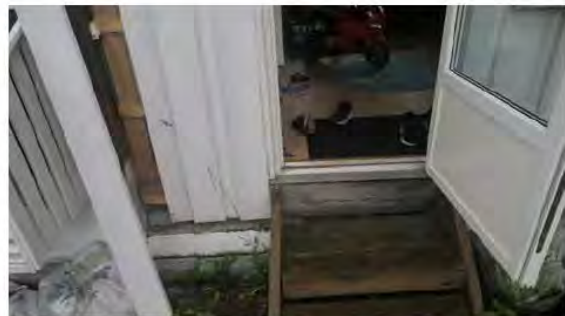
Overgang yttervegg opprinnelig hus/tilbygg.
