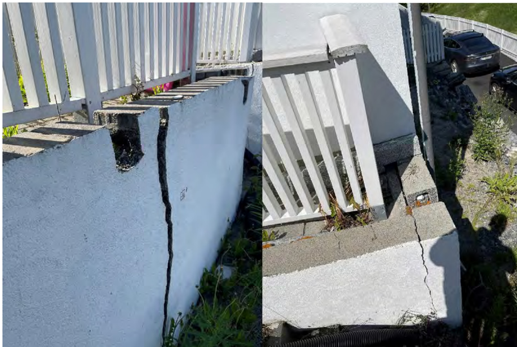
Figur 14: Punkt 16 er plassert på støttemur (bildet til venstre) og punkt 15 er plassert på støttemur ved boligens sørøstlige hjørne (bildet til høyre) like ved en trapp. Det er etablert drenering i toppen av støttemurene, se utspøring i topp mur.
