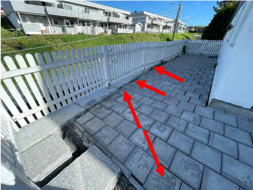
Figur 10: Topp mur like ved bolig. Deformasjon i overgang trapp/støttemur observeres i granittblokker til venstre i bildet. Fall illustreres med røde piler og gir en indikasjon på kreftenes retning. Det er betydelig visuell utvikling fra året før, større sprekker mellom steinhellene, nærmere inn mot boligen enn året før.
