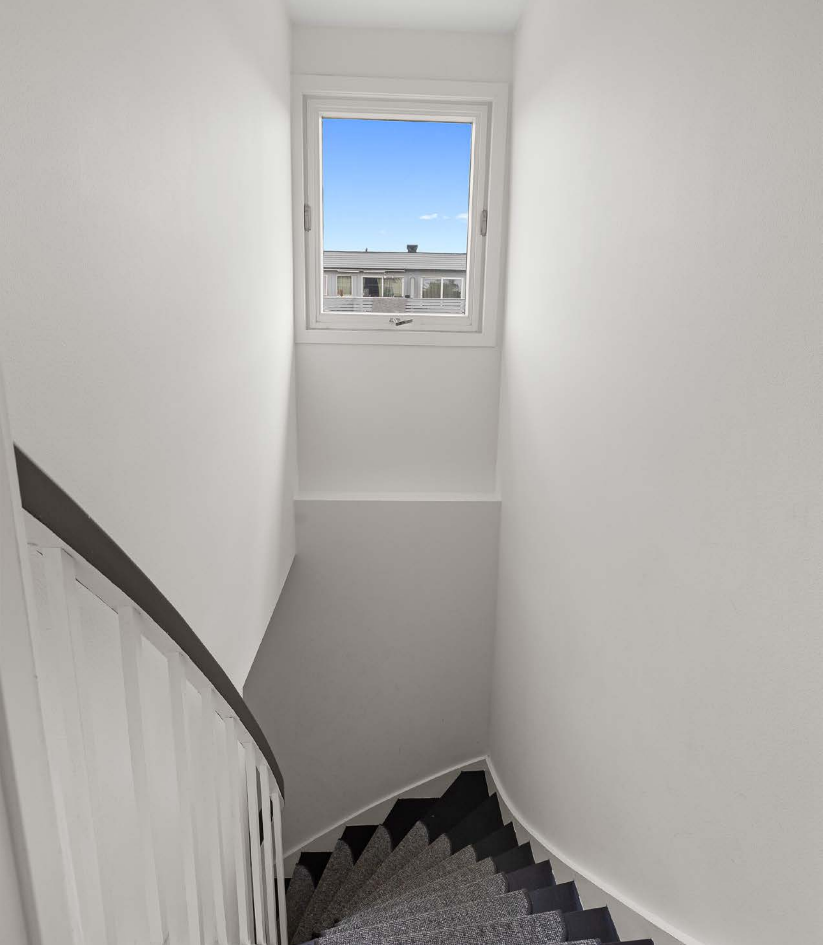
Trapp mellom etasjene.
