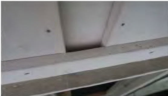
Belasting er lagt utenpå overligger med åpning for vann bak belasting.
