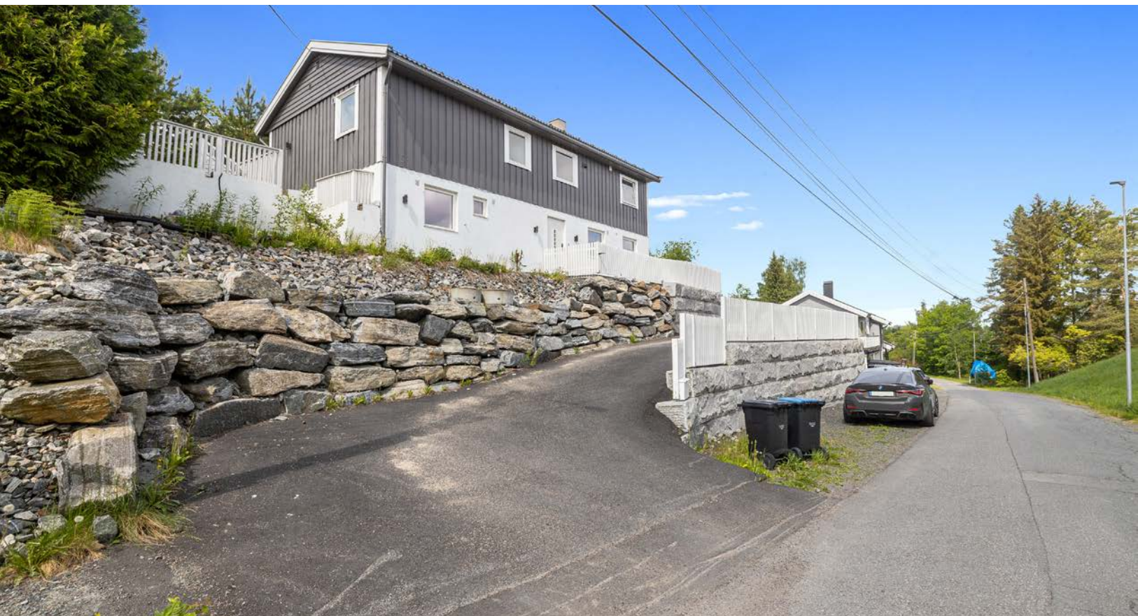
Fasade. Det er adkomst til eiendommen fra Skoleveien, som er kommunal.
