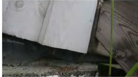
Det er ringmur under trebjelkelag. Ingen støpt plate som beskrevet i salgsopplysninger.
