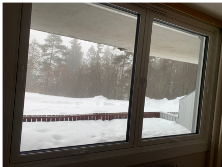
Vinduer med malt treramme
